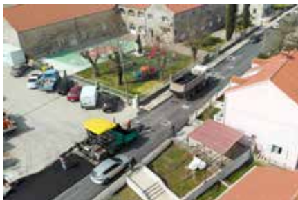
Asfaltiranje na Grudi
